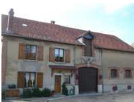
Volets à double écharpe en bois vernis, Ludes
