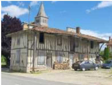
Saint-Amand-sur-Fion Le toit très débordant est une des caractéristiques de ce secteur
