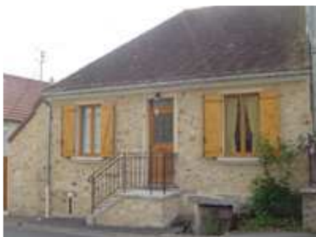
Exemple de maison de vigneron avec escalier extérieur et cave semi-enterrée, Le Breuil
