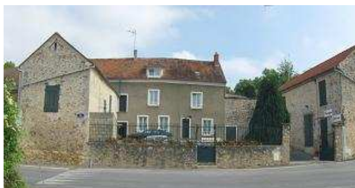
Maison vigneronne en U avec un mur bahut, à Chezy-sur-Marne
