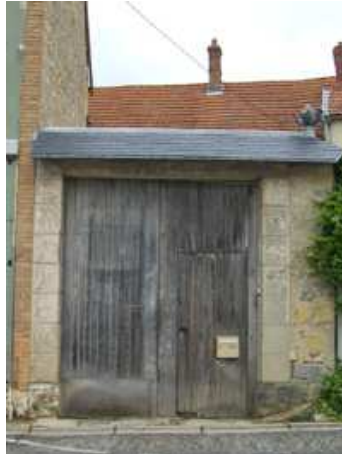
Chesnay Modèle avec une porte piétonne ouvrant dans un des deux battants
