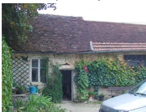
Exemple de maison élémentaire, Celle-sur-Ource
