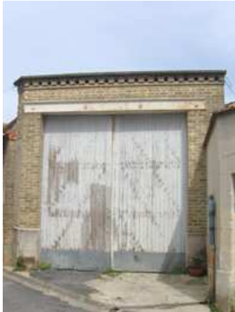
Ambonay La porte en bois est très simple mais il faut noter le décor de la corniche à frise.
