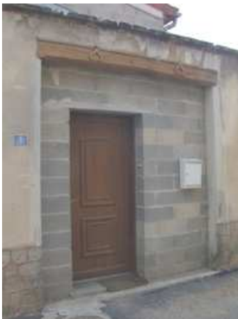
Ancien portail comblé par un mur en parpaings et transformé en porte piétonne, Fleury-la-Rivière
