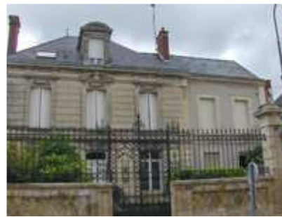
Logis d'une maison de négoce à Rilly-la-Montagne
