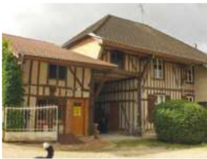
Localisation d'un porte-rue entre les deux parties de l'habitation, Bassuet
