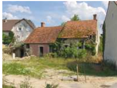
Maisons élémentaires en déshérence où la végétation envahit le terrain et qui bientôt entrera à l'intérieur des bâtiments, Binson-Orquiny
