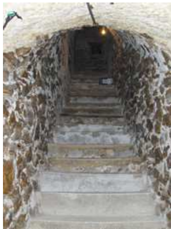
Exemple d'escalier intérieur permettant d'accéder à une cave à Verzenay
