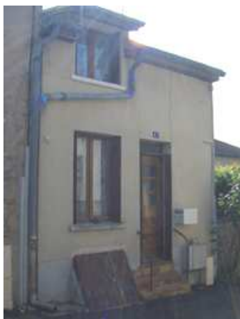
Bel exemple de maison élémentaire de vigneron avec sa porte et sous la fenêtre la cave semi-enterrée, Brasles
