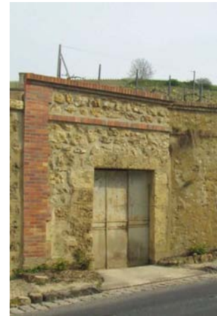
Entrée de cave à flanc de coteau à Aÿ
