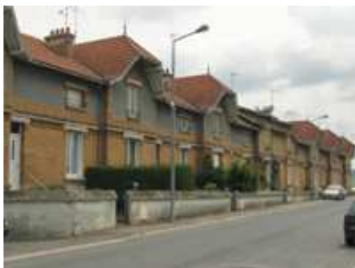
Linéaire de maisons ouvrières, Sillery
