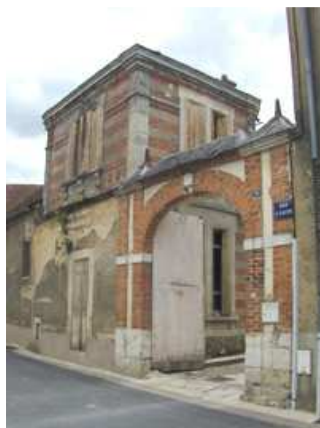
Piliers en briques, Avize
