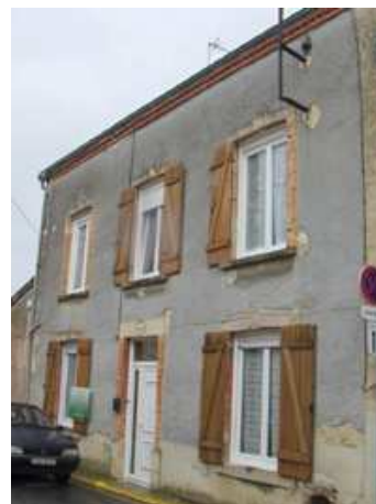
Volets pleins vernis à double écharpe en Z, Coulommès-la-Montagne
