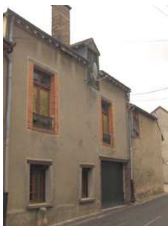
Antenne parabolique dénaturant la façade et cachant une lucarne engagée, Verzenay
