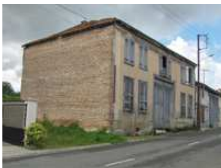
Mur pignon en graveluche, Bassu
