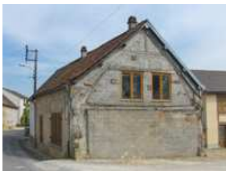
Percement d'un pignon par deux fenêtres pour permettre la transformation d'un ancien grenier aveugle en pièce à vivre, Congy
