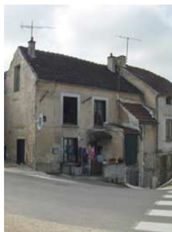
Maison de vigneron sur deux niveaux, Chezy-sur-Marne
