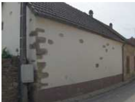
Restauration avec un enduit lisse au ciment en place d'un enduit à pierre vue, Congy
