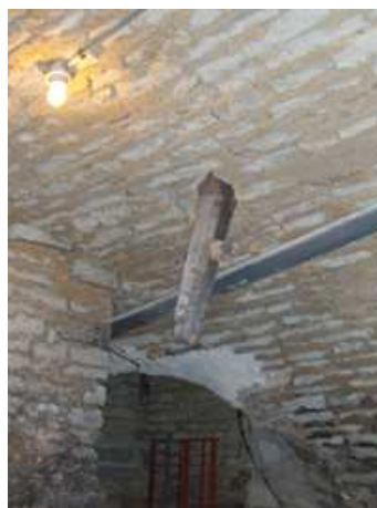
Exemple de « goulotte » permettant de relier la vinée à la cave, Les Riceys
