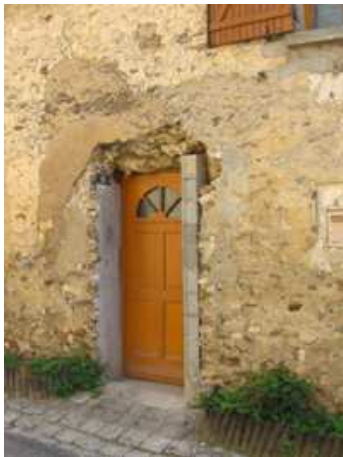
Ouverture percée avec entourage de parpaing et porte en bois vernis, Gland
