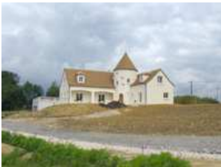
Maison moderne construite sur un promontoire, Allemant
