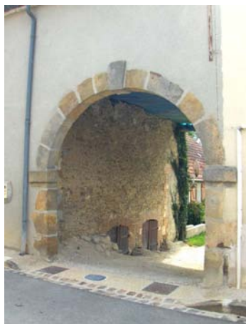
Deux entrées de caves sous un porche, villenauxe-la-Grande
