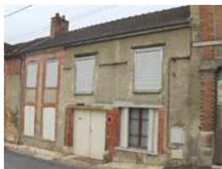
Pose de volets modernes mécaniques sur une façade ancienne, Cumières
