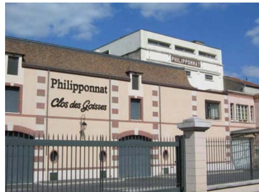
Bâtiments Philipponnat à Mareuil-sur-Aÿ Construction nouvelle avec rappel de certains éléments classiques
